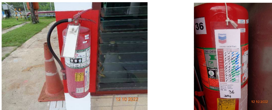
รูปที่ 3-30 การตรวจสอบประสิทธิภาพอุปกรณ์ดับเพลิง
